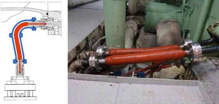
Figura 16: Exemplos de tubulação encamisada.
