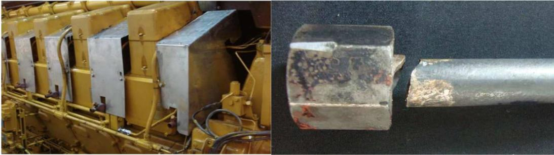
Figura 10: Proteção instalada para evitar spray por quebra em tubulação de diesel.
