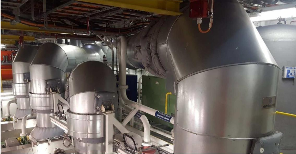
Figura 26: Linha de exaustão completamente vedada em conexões entre seções e curvas, sem possibilidade de ingresso de óleo diesel/lubrificante.
