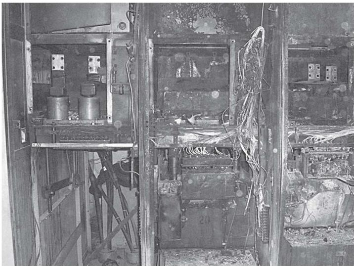
Figura 4: Painel elétrico após curto circuito.
