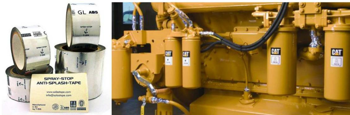
Figura 15: Fita anti-spray adequadamente instalada em conexões pressurizadas dos motogeradores.
