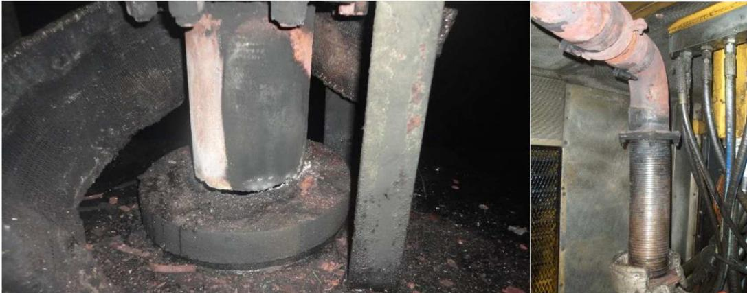
Figura 28: Linha de exaustão acima do piso acima da sala de máquinas do guindaste e linha de exaustão do motor no compartimento de máquinas do guindaste.
