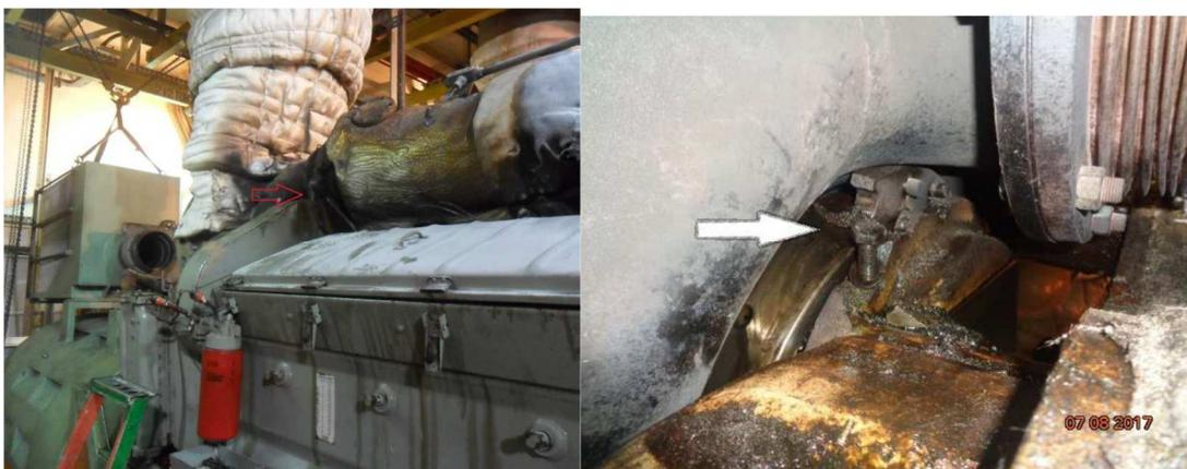
Figura 30: Local e parte da turbina danificada levando ao princípio de incêndio.
